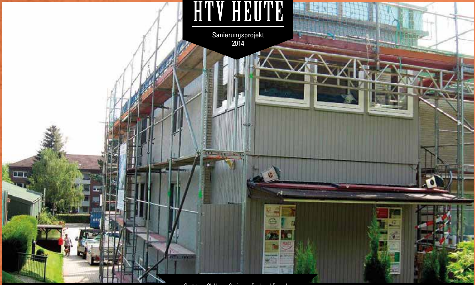
Gerüst am Clubhaus. Sanierung Dach und Fassade.
