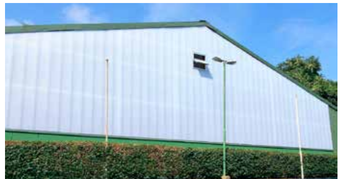
Blaue Halle nachher mit neuen 8-fach Stegplatten.
